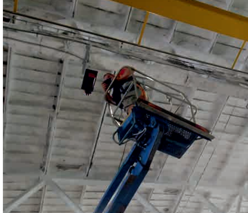
Montáž laserových navigátorov vo výrobnej hale
